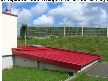
Silo enterré, chaufferie bois de Dozulé
